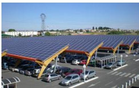
**Figure 7. Ombrières photovoltaïques sur une aire de stationnement**
