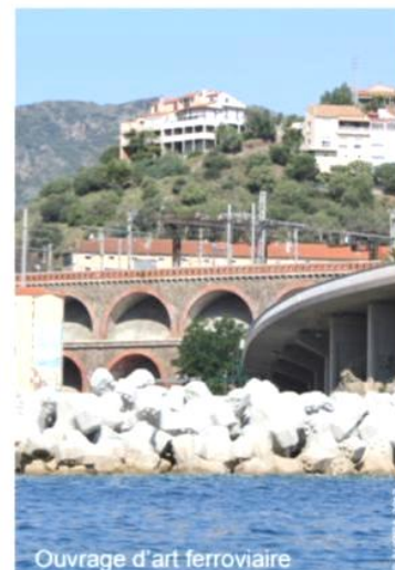
Ouvrage d'art ferroviaire
