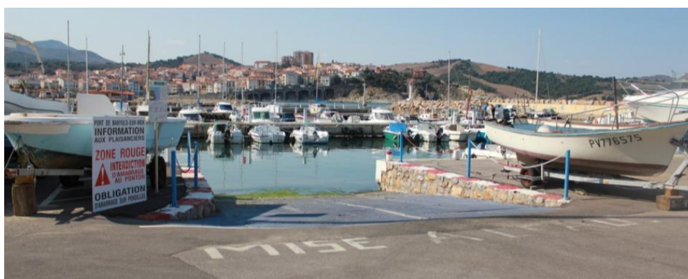
Cale de mise à l'eau dans le port de Banyuls-sur-Mer.
