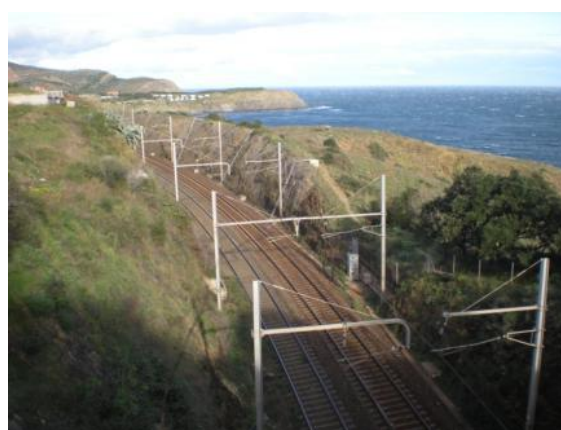
Ligne régionale entre Cerbère et Peyrefitte
