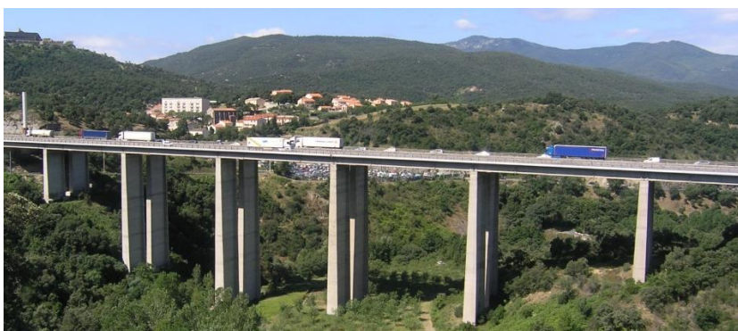
Le viaduc des Cluses (Source AURCA)
